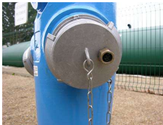
Poteau d'aspiration de 150 mm muni d'un Airclap
