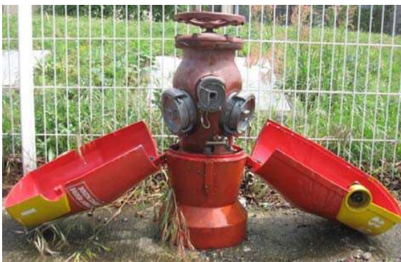
Poteau Incendie de 150 mm avec deux sorties de 100 mm et une sortie de 65 mm
