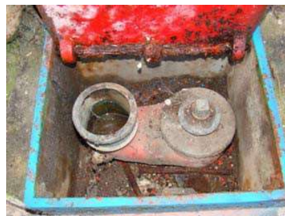
Bouche Incendie de 80 mm à raccord Keyser
