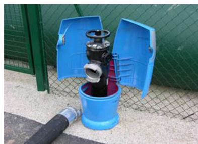
Poteau d'aspiration de 100 mm
